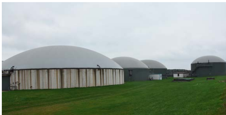
Nutrition & Food, Deutschlands größte Welszucht, ist Teil der Bioenergie Lüchow und nutzt die Abwärme der Biogas-Anlagen.
